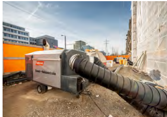
Montaggio e installazione da parte degli specialisti della Krüger
