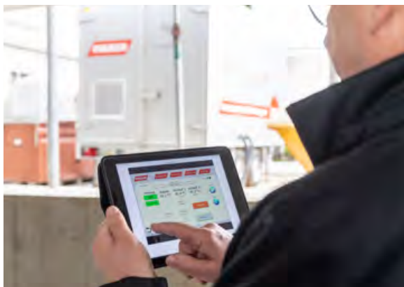
Contrôle à distance d'un chauffage
