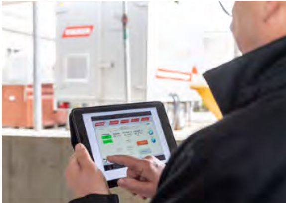
Fernüberwachung einer Heizzentrale
