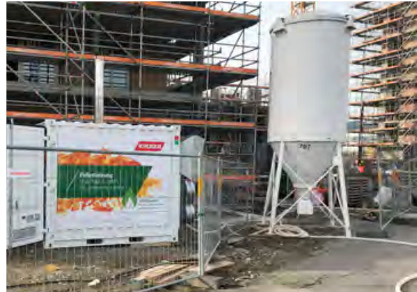
Pelletheizung mit 220 kW
