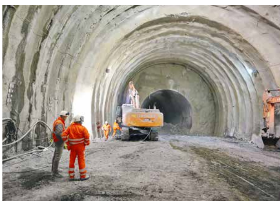
Costruzione di gallerie
