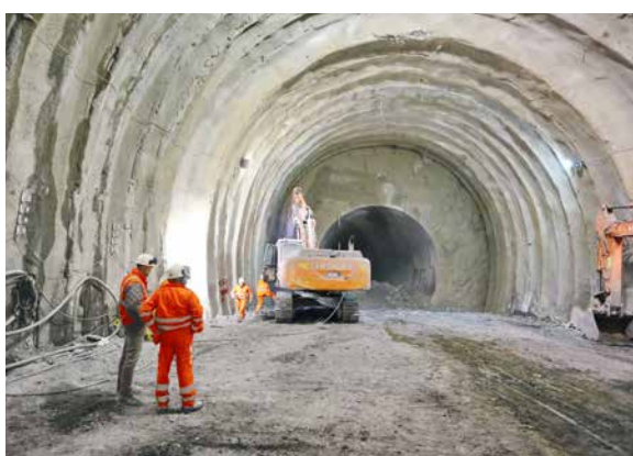
Construction de tunnels
