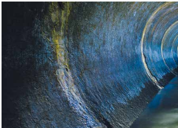
Curage de canalisations
