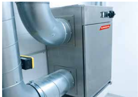
Les déshumidificateurs à adsorption de Krüger protègent les documents et œuvres d'art d'une détérioration, voire d'une destruction grâce à l'instauration d'un climat optimal.
