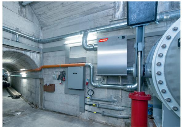
Die Anlagen von Krüger vermeiden Schäden durch hohen Kondenswasseranfall an den Installationen und am Gebäude.
