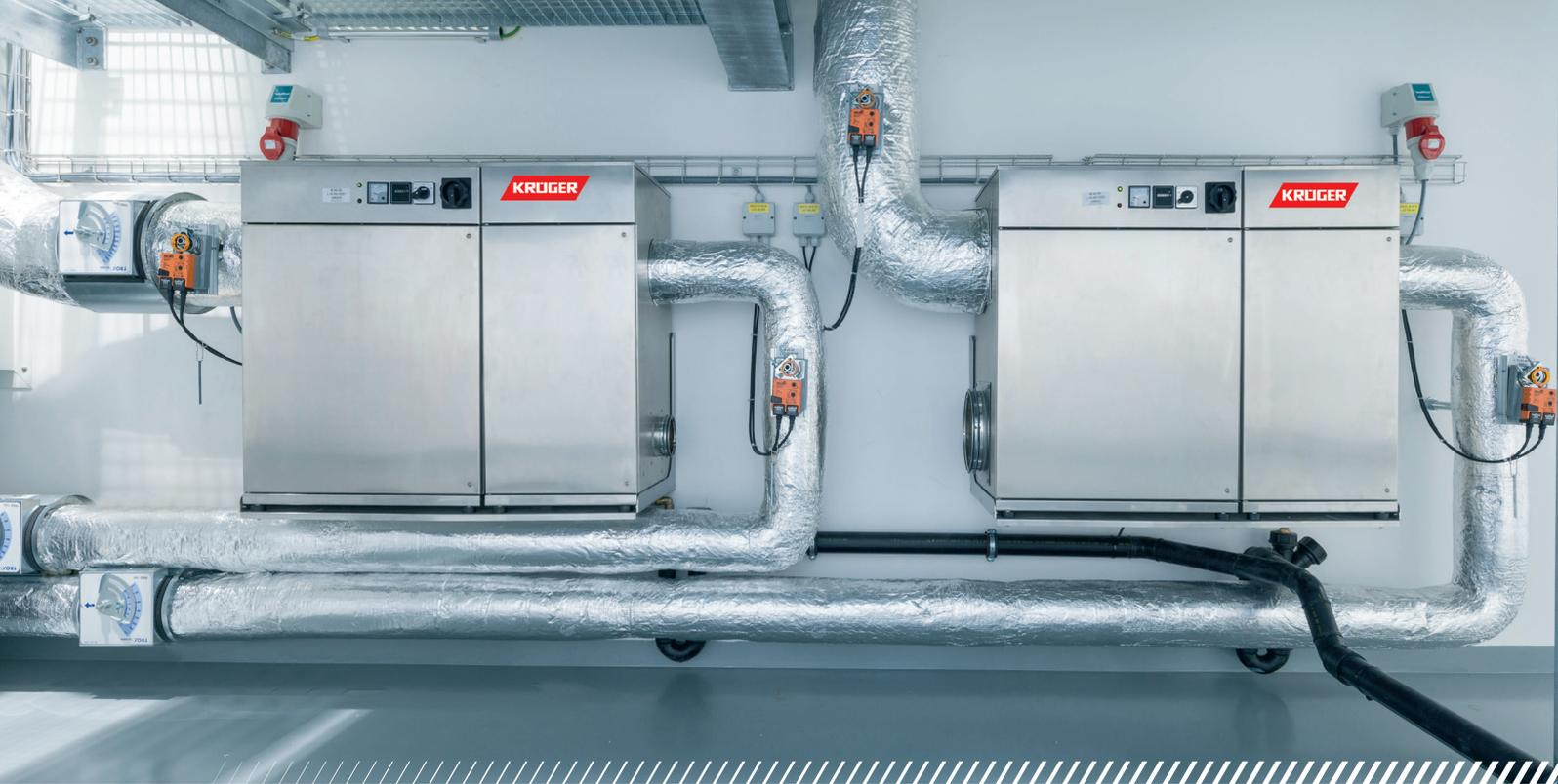
Die Luft wird bei dieser Technik durch einen Filter angesaugt und über das langsam rotierende Trockenrad geführt. Hier findet der Feuchtigkeitsaustausch statt. Die Wassermoleküle binden sich an den Sorptionskörper. Die vom Trockenrad adsorbierte Feuchtigkeit wird im separierten Regenerationssektor durch einen im Gegenstrom geführten heißen Luftstrom wieder ausgetrieben und an die Umgebungsluft abgegeben.
