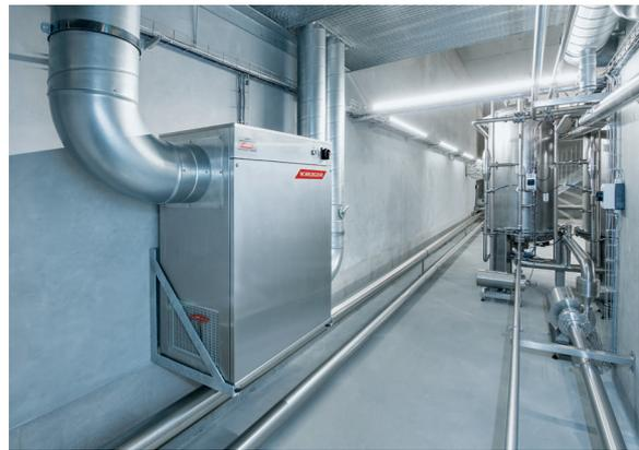
Dank dem Einsatz unserer Geräte werden die Armaturen sowie das ganze Gebäude vor Feuchteschäden geschützt.
