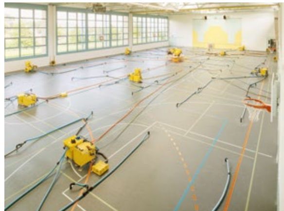
Isolationstrocknung in Turnhalle
