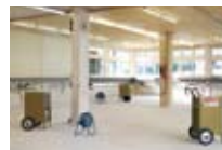
Bautrocknung
